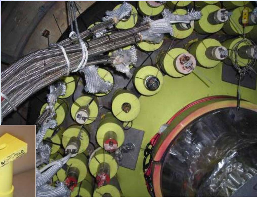
Силиконовая защита для нагревателя компенсатора давления и сопла
