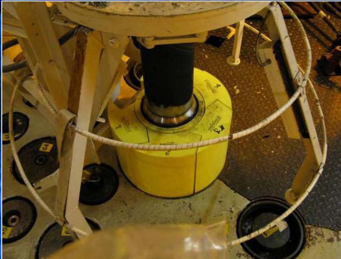
Изготовленный из материала *Radishield* и состоящий из нескольких сегментов силиконово-свинцовый экран для блока **Control Plug**
